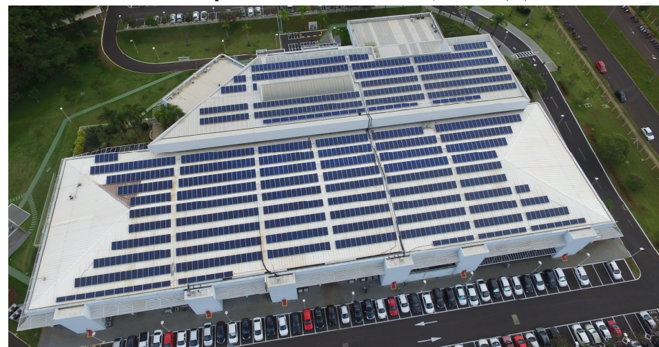
Edifício comercial ou industrial: data center, Uberlândia (MG).
